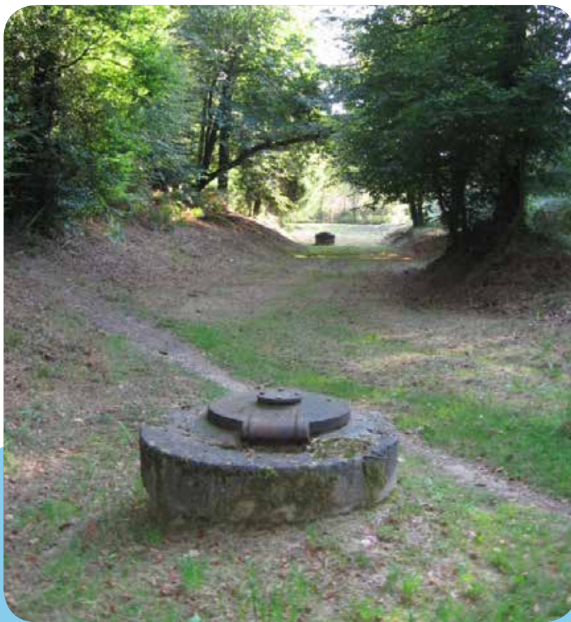
Drains de la forêt de Fougères (35) – Photo SMG35
