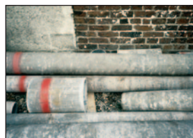
© INRS Canalisation en amiante ciment
