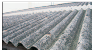
© INRS Toiture en amiante ciment
