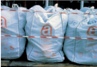
© INRS Déchets amiantés
