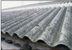
© INRS Toiture en amiante ciment
