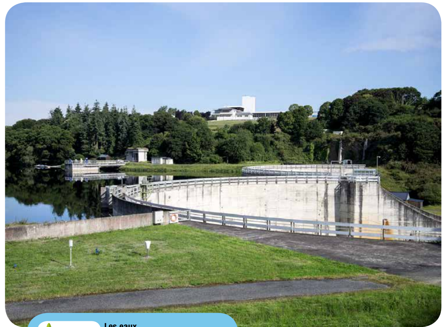
Barrage et prise d'eau de l'Arguenon à Pleven (22) Photo agence TOTEM – Antoine de Givenchy
